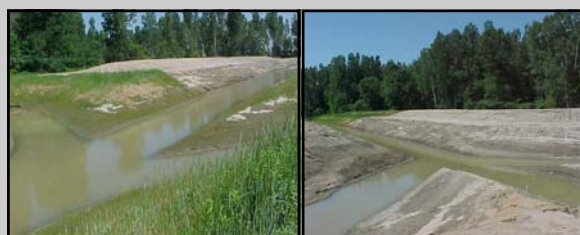
Fossé piscicole aménagé à Yamachiche.
