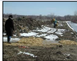
Stabilisation des pentes en milieu agricole.
